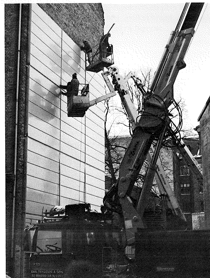
Figur 44. Justering af komponentplacering samt fastgørelse af komponent fra lifter.
