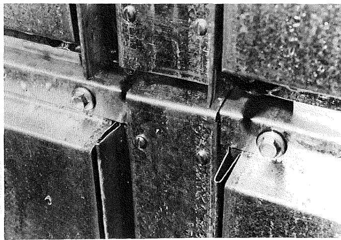
Figur 52. Nærbillede af fugekryds mellem stålkomponenter med dækplade foran lodret fuge ført ind i vandret fuge.
