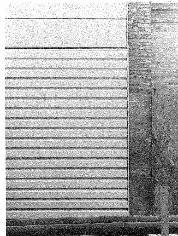
Figur 45. Lodret kant af beklædning før udførelse af afslutning ved gavlhjørne.
