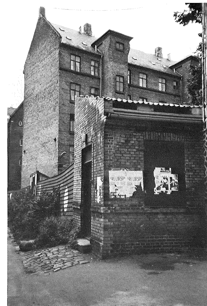
Figur 18. Gavlen og gårdfacaden, Ryegade 119 B.
