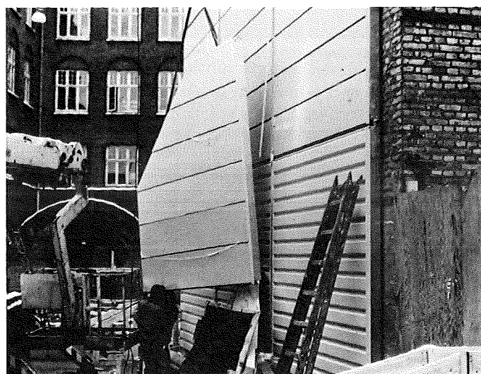
Figur 42. Anbringelse af fugemateriale i not i komponentens bundskinne.
