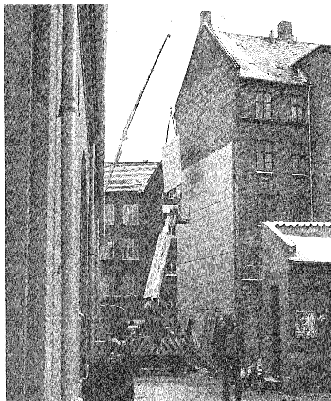
Figur 43. Styring og placering af komponent fra lifter.
