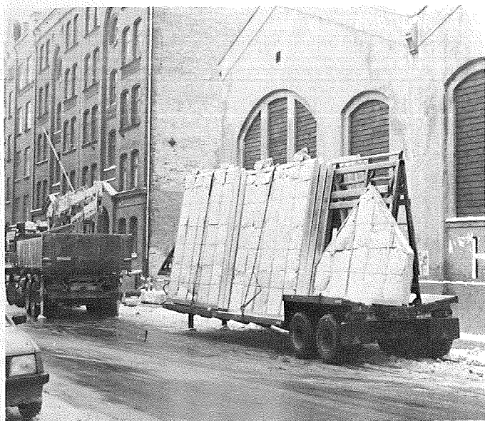
Figur 40. Komponenter på sættevogn på gaden.
